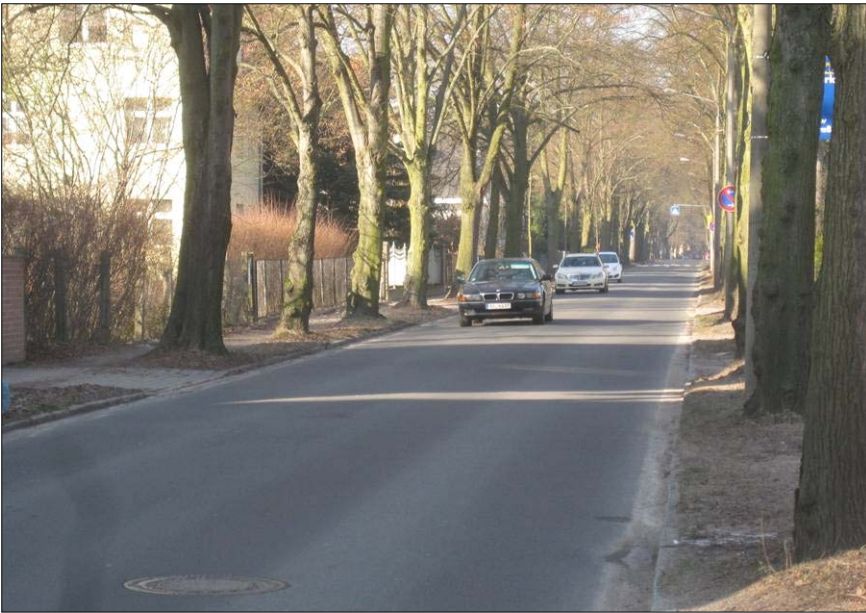
Meiereifeld – Fahrbahn und Borde (ohne Absenkung an Einmündungen)
